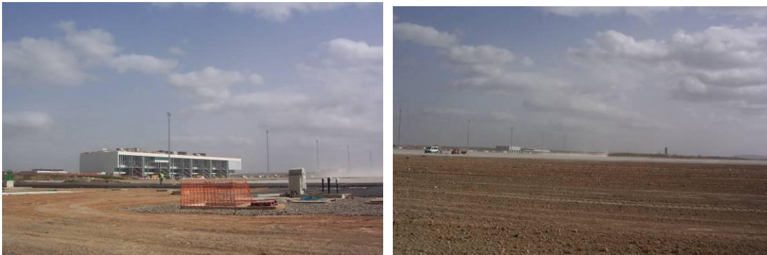
Foto 1: Obras del Aeropuerto de Don Quijote en la ZEPA Campo de Calatrava. Ciudad Real, 2008.
